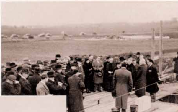
Pose de la première pierre à Louvetot.
