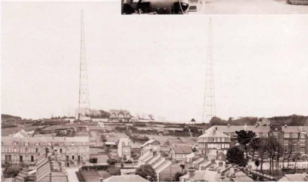
Vue générale en Avril 1933.
