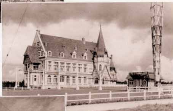
Louvetot. — Le bâtiment principal et la base du pylône de 170 mètres.
