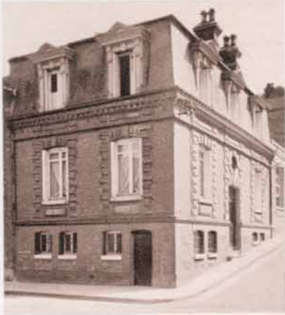
Maison de la Radio. Vue générale.
