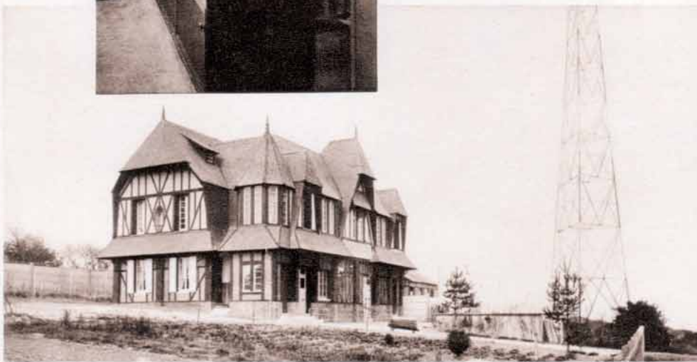
Les nouveaux bâtiments de Fécamp en 1935.
